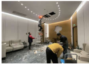
对一楼VIP室空调进行改造
